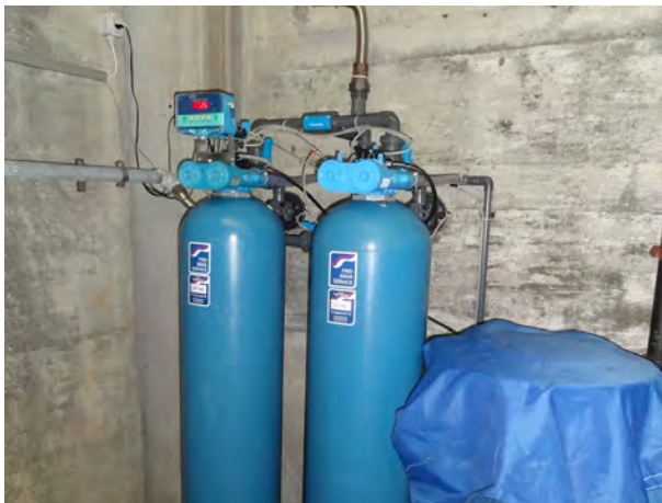
Wasserenthärtungsanlage
