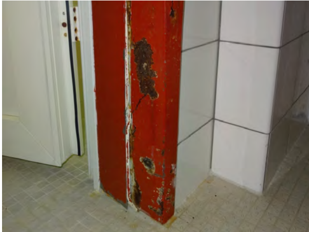
verrostete Türzarge mit aufgedoppelter Türe in Kunststoff
