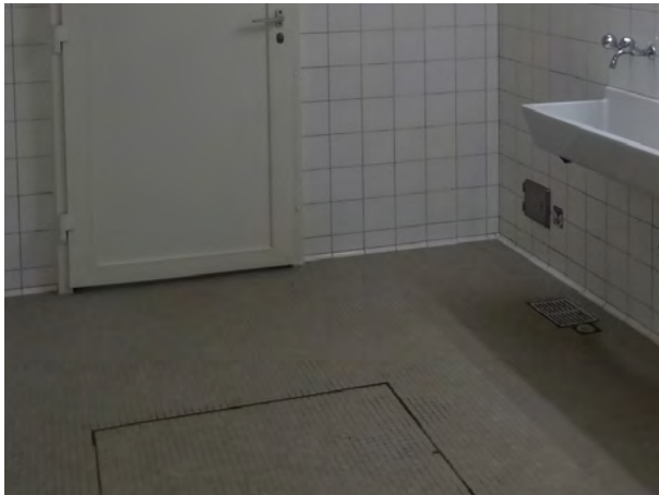
Nassräume Mosaikboden mit Bodenablauf und Schachtrahmen
