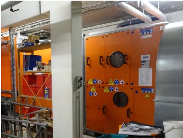
Lüftungsgerät Schwimmhalle
