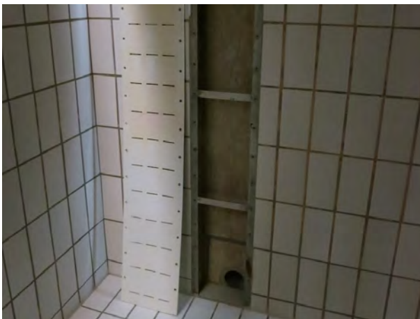
Beckeneinströmung an der Stirnseite des Beckens
