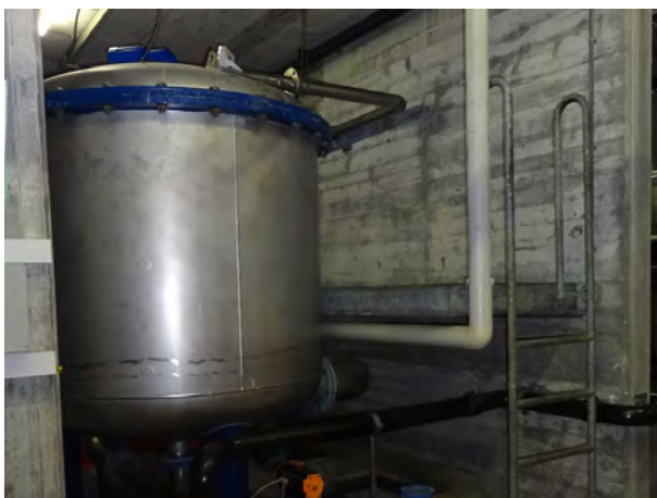
Kieselgur-Druckanschwemmfilter
