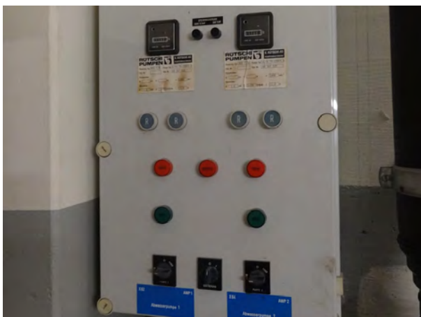
Steuerung Abwasserpumpen
