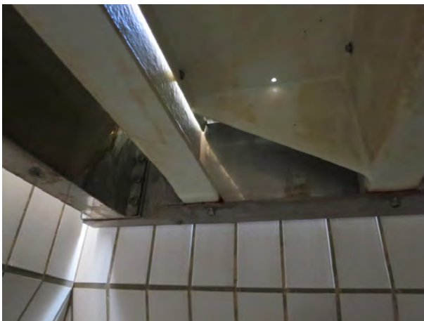
Unterkonstruktion Hubboden
