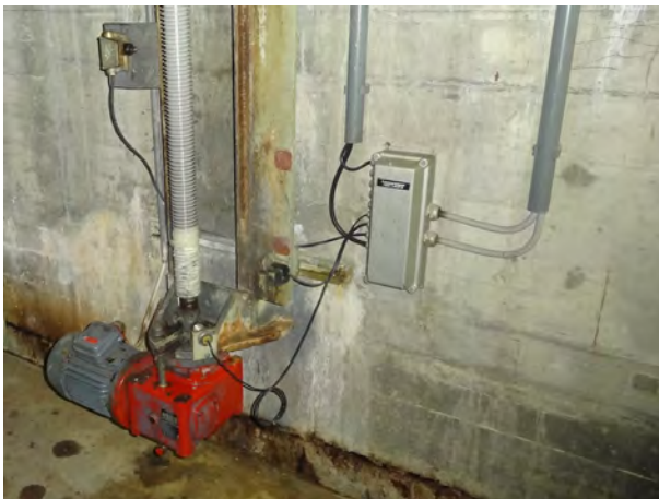
Spindelantrieb Hubboden
