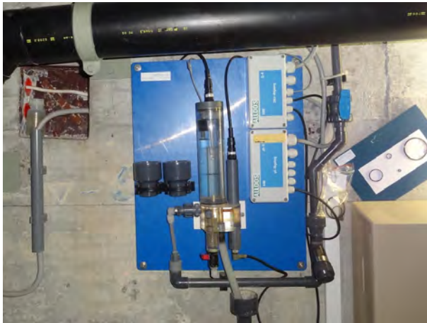
Dosiergerät für Chlor-Regelung und pH-Regelung
