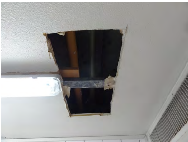
Reparaturöffnung in abgehängter Decke mit verputzten Gipskartonplatten
