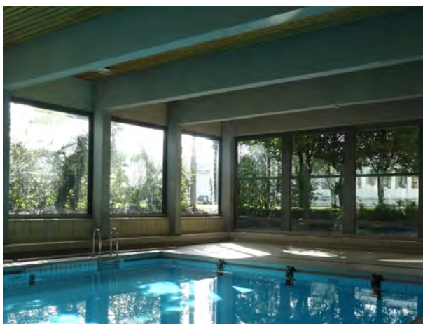
Fensterfronten in der Schwimmhalle
