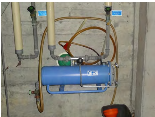
Zumischgerät Fussdesinfektion
