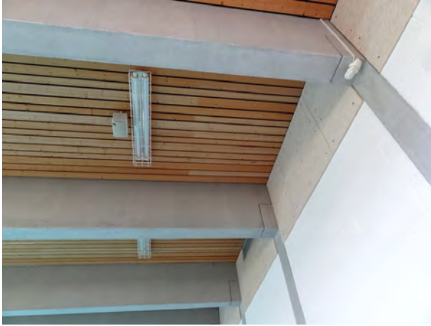
Deckenuntersicht in Holz
