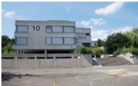
Haus D: Hauptgebäude 1967
