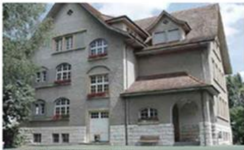
Haus G: Schulgebäude 1911
