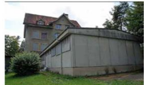
Haus I: Pavillon 1966
