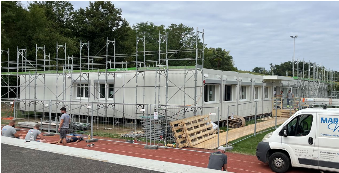
Installation des neuen Schulraum-Pavillons Egg (August 2024)
