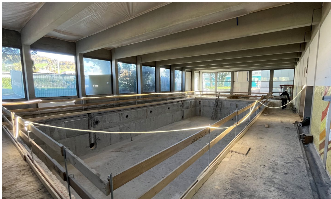
Sanierung der Schwimmhalle (Oktober 2024)
