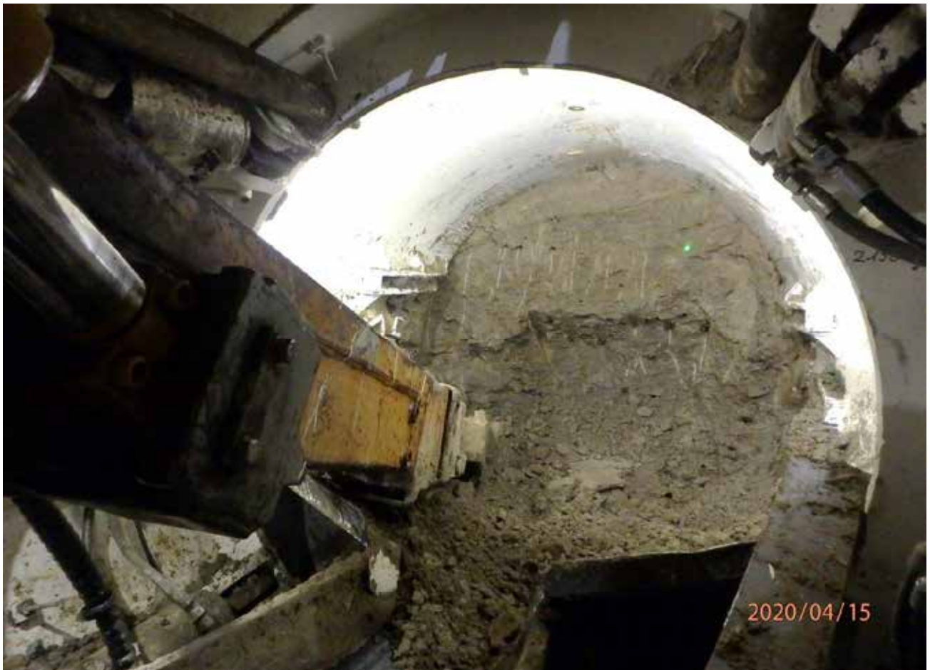
Der Arbeitsplatz des Vortriebspoliers. Mit dem Stollenbagger wird der Felsuntergrund an der Ortsbrust abgebaut.
