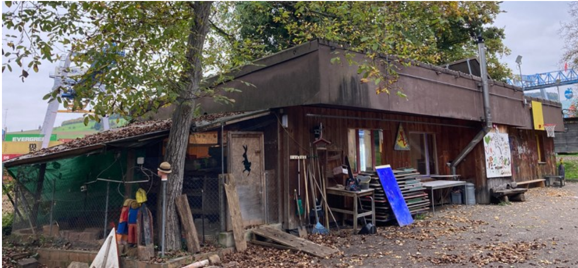
Abb.1: bestehendes Hauptgebäude mit anliegendem Nagergehege.
