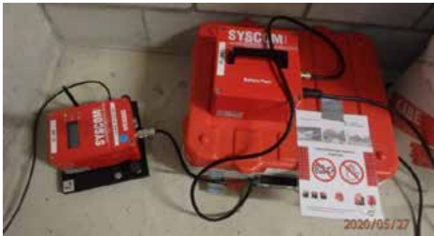
Messgerät zur Erschütterungsüberwachung im Einsatz.
