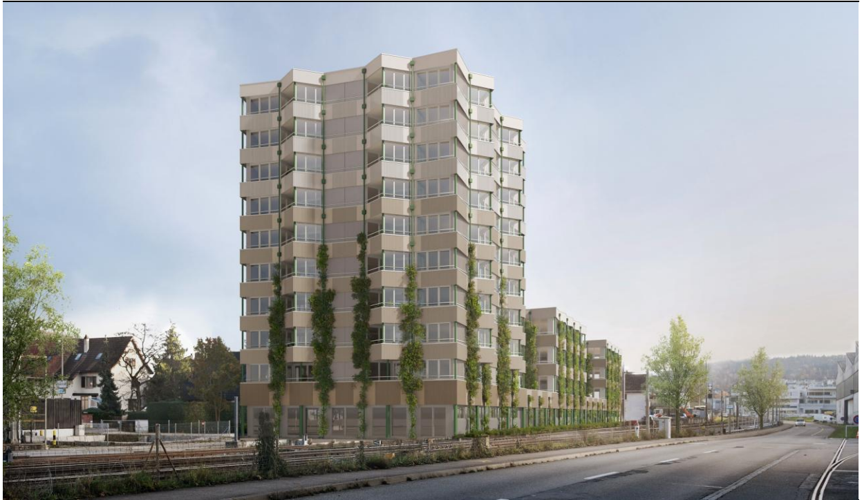
Abb. 6: Blick von Nordwest (Ramser Schmid Architekten)
