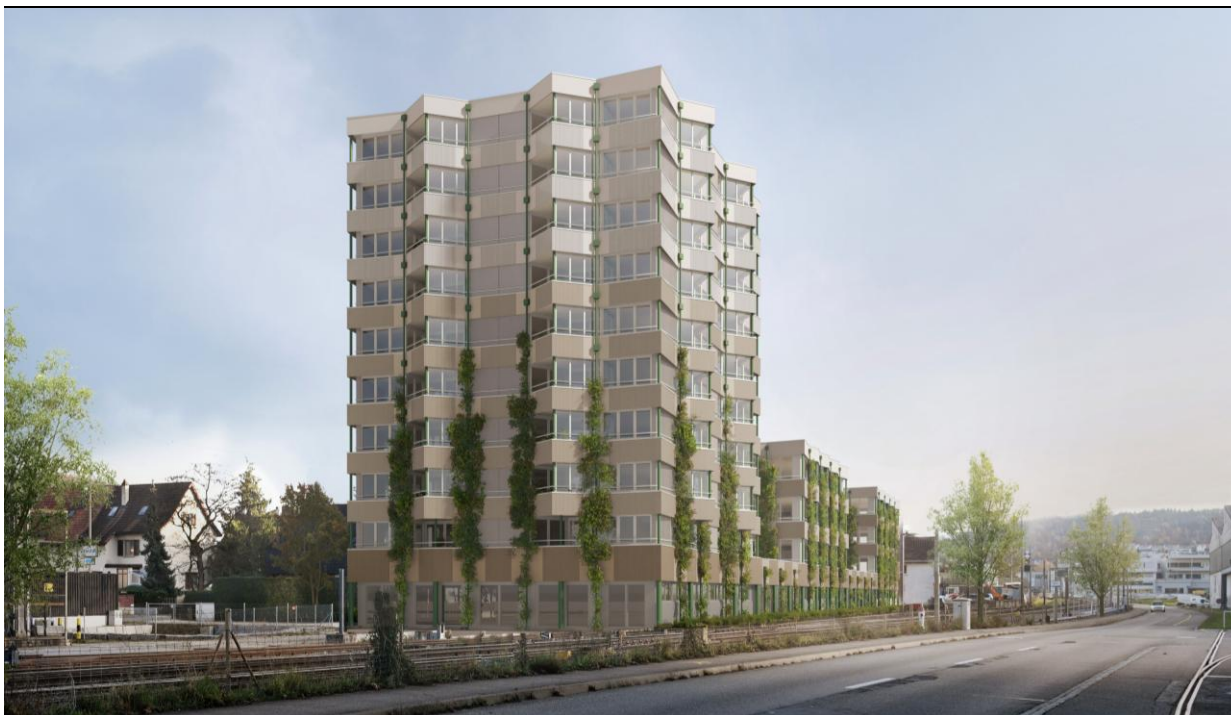
Abb. 6: Blick von Nordwest (Ramser Schmid Architekten)
