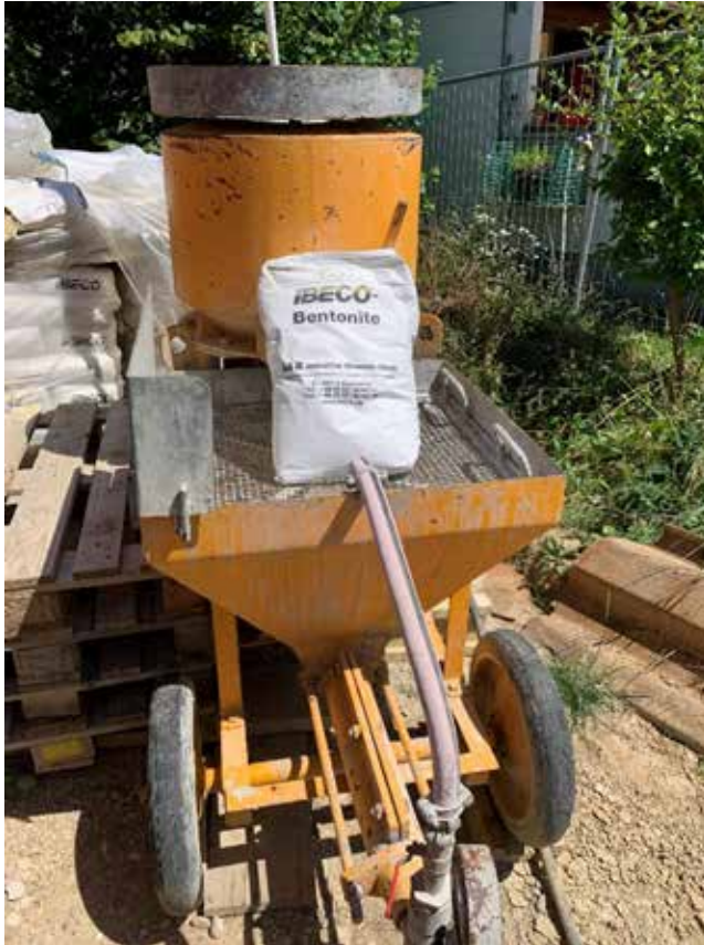
Förderpumpe mit einem Sack Bentonit (Gebinde à 25kg).
