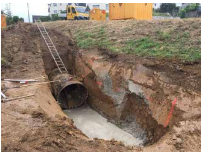
Die freigelegte Vortriebsmaschine.
