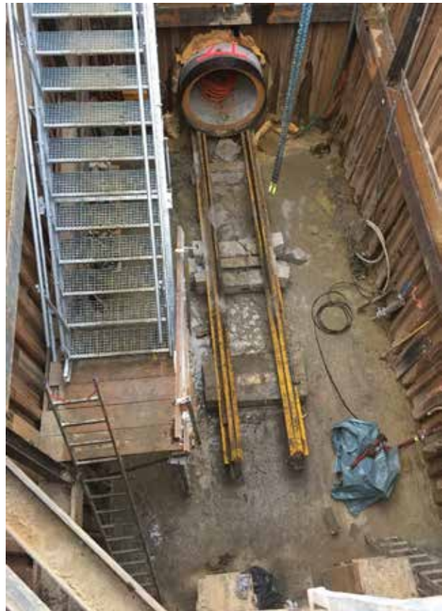
Umbauten in der Startgrube an der Adlegasse.
