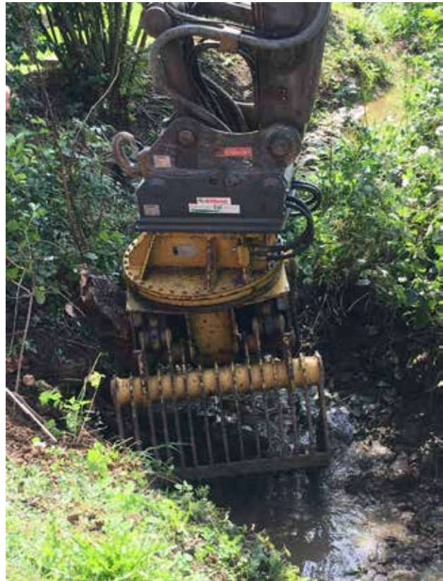
Das Entfernen der alten Betonplatten ermöglicht eine natürliche Bachdynamik, wobei standort-heimische Sträucher und Bäume Schutz gegen Erosion bieten
