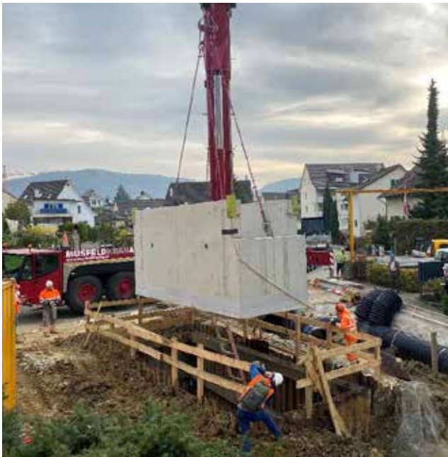
Einlaufbauwerk: Versetzen des Bauteils 1
