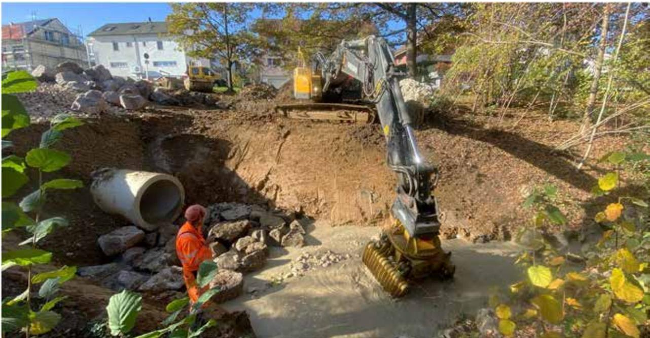
Der Auslauf des Bypasses beim Hofmattweg (linker Bildrand). Mit dem Bagger wird eine neue Bachsohle erstellt.
