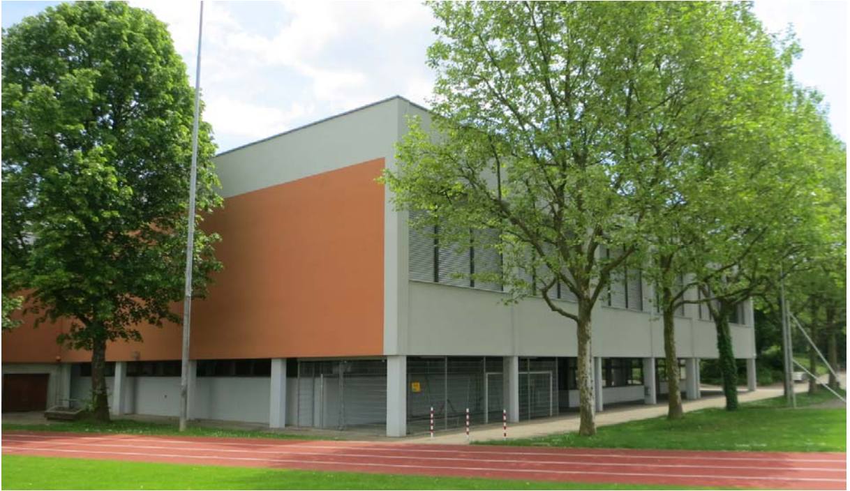
Nord-West-Ecke des Turnhallen-Traktes ( heutige Situation )
