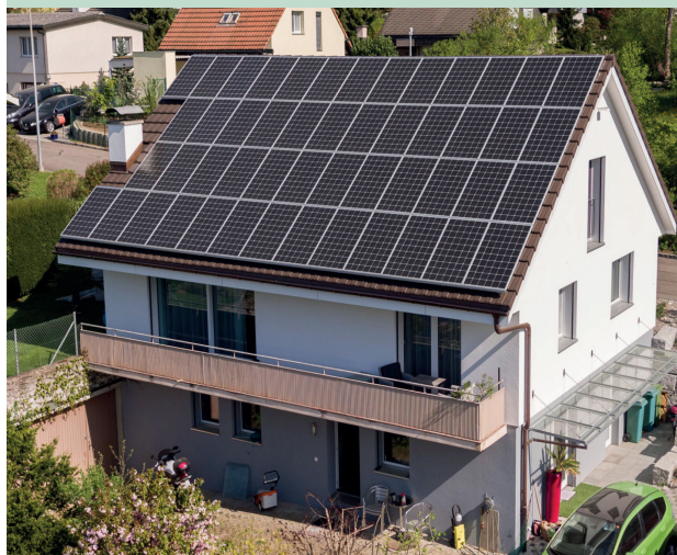
Einfamilienhaus mit PV-Anlage auf dem Dach - Bild: S. und T. Routil
