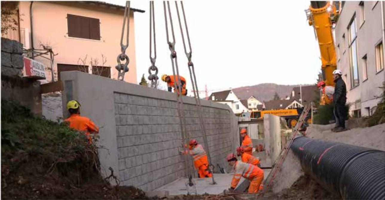
Mit einem der grössten Pneukrane der Schweiz wird ein Betonelement des Einlaufbauwerks versetzt.
