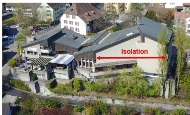
Bild 3 Ostseitige Fassade ( u -Wert 2.5 im Saalbereich)
