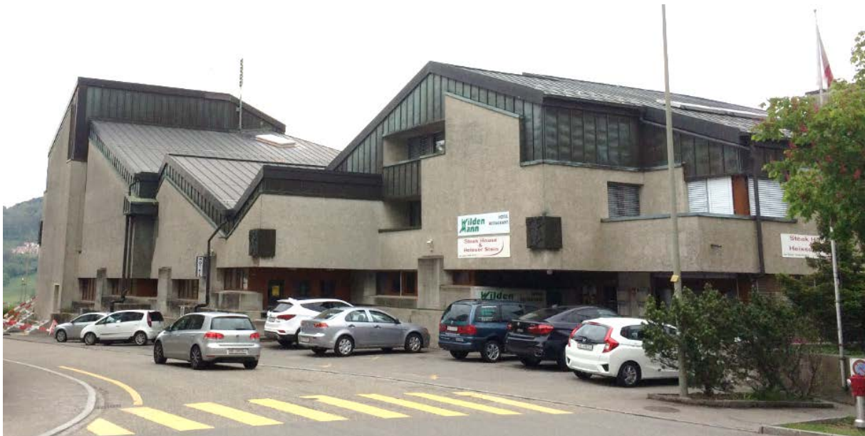
Bild 1 Westseitige Fassade des Wilden Manns ( u -Wert 1.05 \text{ W/m}^2/\text{K} im Saalbereich)
