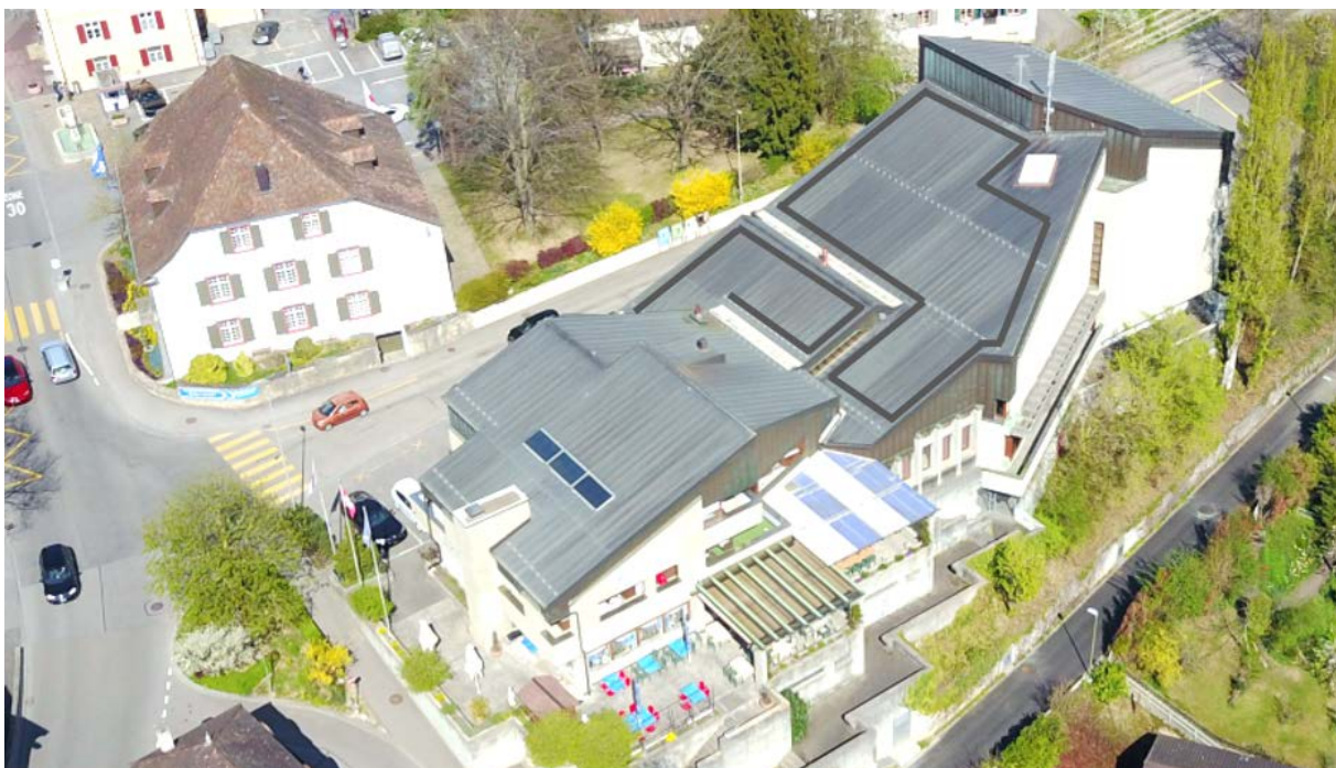
Bild 11 Dachbereiche für die geplante PV-Anlage auf dem Saal des Wilden Manns
