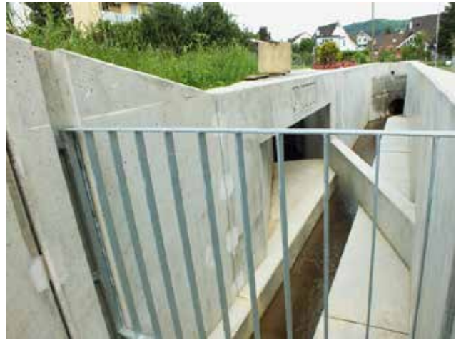
Das Einlaufbauwerk an der Adlerfeldstrasse besteht aus Betonelementen mit Einzelgewichten von bis zu 69 Tonnen.
