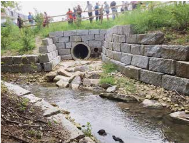
Das Ufer des Hülftenbächlis wurde beim Auslaufbauwerk unweit der «Egg» mit Blockmauern verstärkt.
