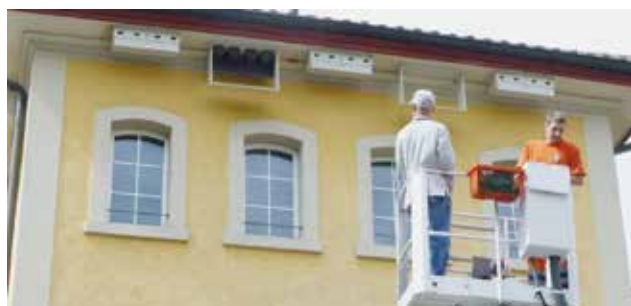
Montage der neuen Nisthilfen
