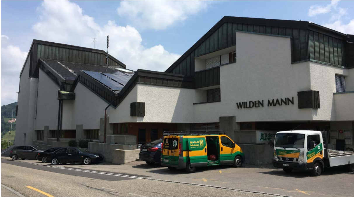
Wilden Mann im neuen «Kleid» und der Photovoltaik-Anlage auf dem Saal-Dach
