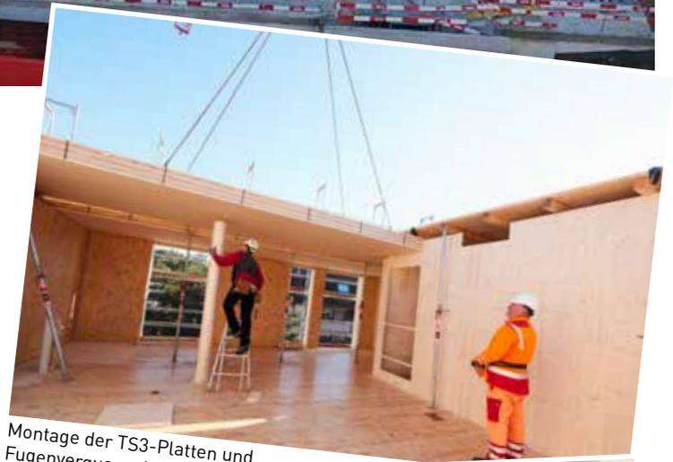
Montage der TS3-Platten und Fugenverguss mit TS3-Giessharz.
