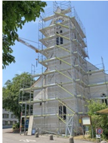
Die Renovationsarbeiten an der Kirche St. Margaretha in Frenkendorf haben begonnen.
