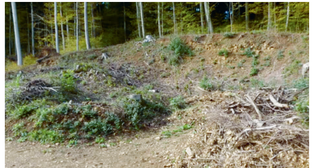
Ehemalige Steingrube am Paradiesweg, die zu einem Wendeplatz ausgebaut wird.
