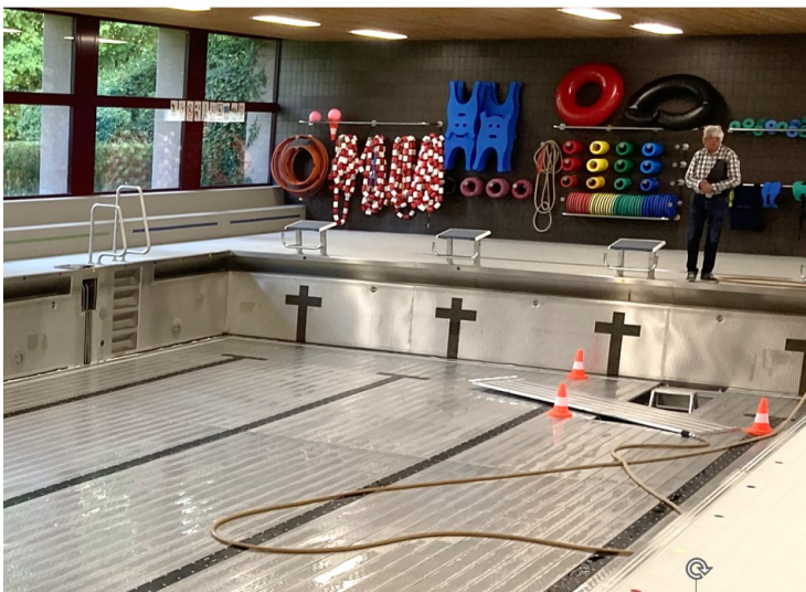
Bild 3 Neue Edelstahl-Beckenauskleidung und -Hubboden (Besichtigung Okt. 2022 der sanierten Schwimmhalle Grünau in Zürich; aus Sicherheitsgründen verzichten wir auf die dargestellten Startblöcke)
