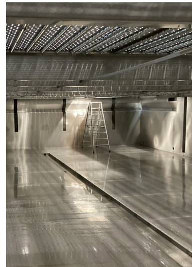
Bild 3 Neue Edelstahl-Beckenauskleidung und -Hubboden (Besichtigung Okt. 2022 der sanierten Schwimmhalle Grünau in Zürich; aus Sicherheitsgründen verzichten wir auf die dargestellten Startblöcke)
