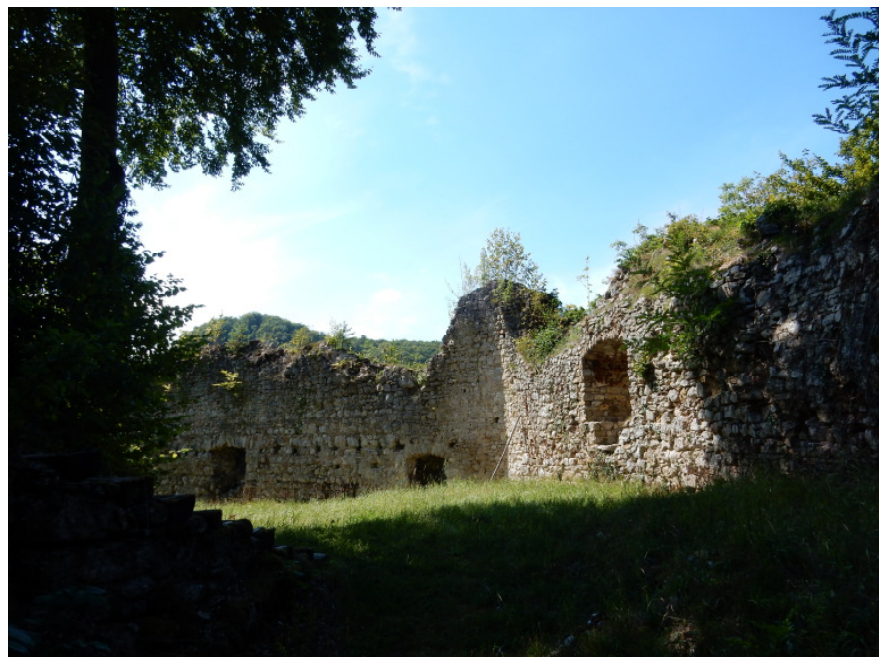
Abbildung: Mauern und Mauerkronen der Ruine Schauenburg tragen Trockenvegetation. Die Krautpflanzen schaden dem Mauerwerk nicht.
