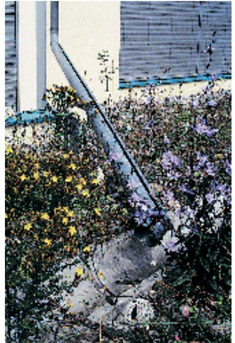
Fallrohr und Ablaufrinne für das Dachwasser
