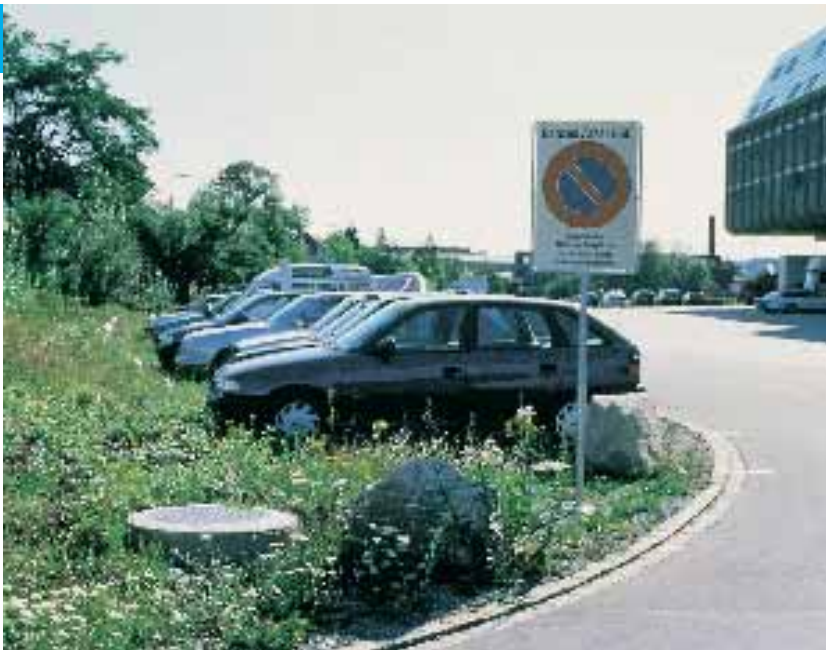
Das Dachwasser versickert in der Versickerungsgalerie unter den Parkplätzen
