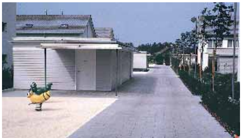
Interne Verbindungswege aus porösen Pflastersteinen
