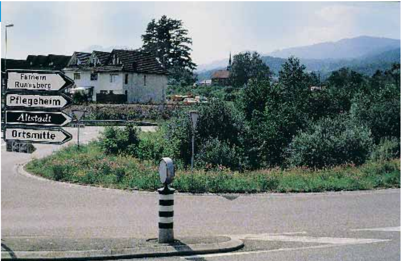
Retentions- und Versickerungsbecken mitten im Strassenkreisel
