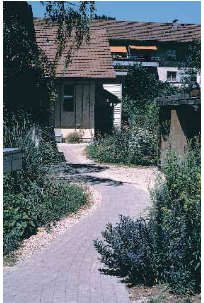
Pflastersteine mit seitlichen Kiesstreifen
