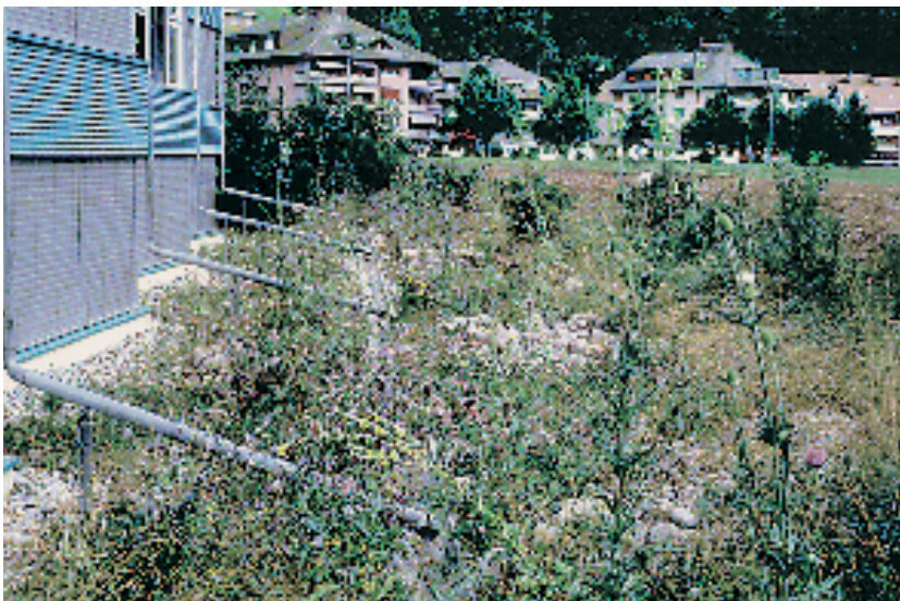
In der offenen Ablaufrinne fließt das Dachwasser zum Biotop
