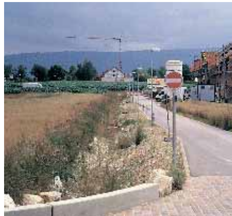
Offener Entwässerungsgraben längs der Strasse für Dach- und Strassenwasser
