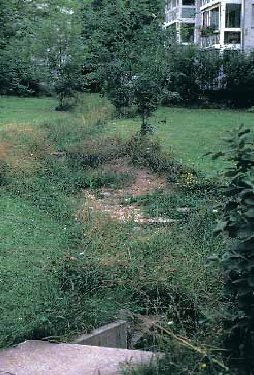
Offenes Gerinne in der Siedlung, in dem das Regenwasser abgeleitet wird
