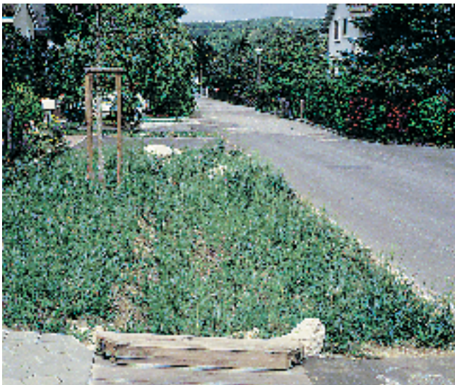
Seitlicher Versickerungsgraben
