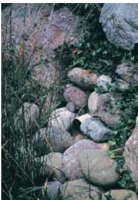
Einlauf des Dachwassers in die Versickerungsmulde
