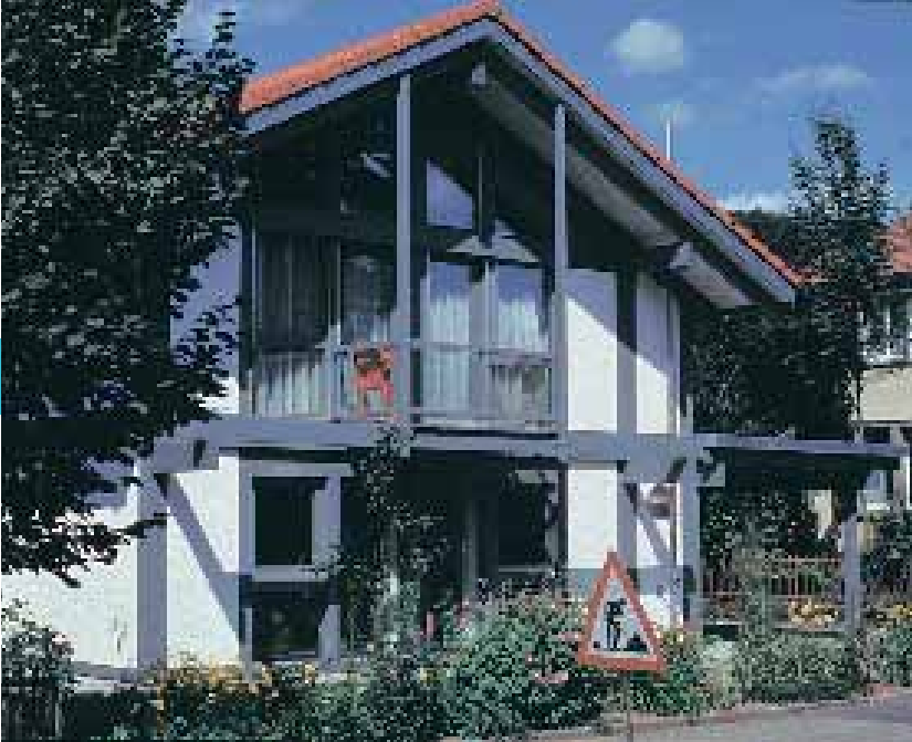
Zufahrt und Umgebungswege sind mit Kies bedeckt. Das Regenwasser kann direkt versickern
