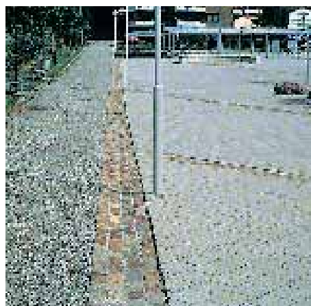
Das Regenwasser des Schulhausplatzes fließt oberflächlich zum Bach.
