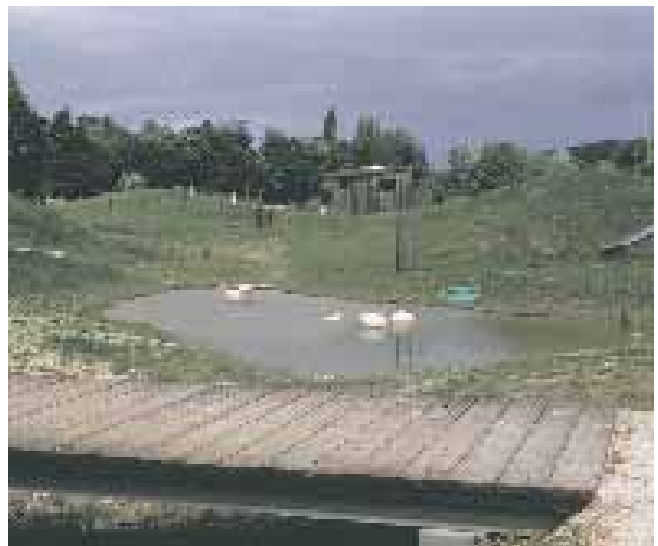
Retentionsbecken im Bereich des Robinsonspielfeldes
