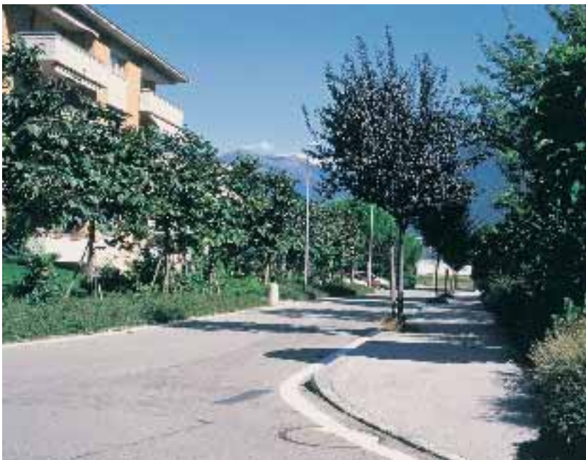
Die Versickerungsanlage befindet
