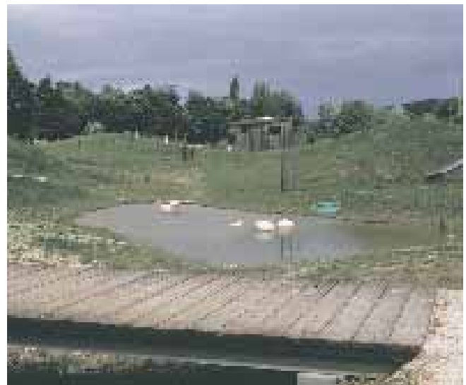
Retentionsbecken im Bereich des Robinsonsplatzes
