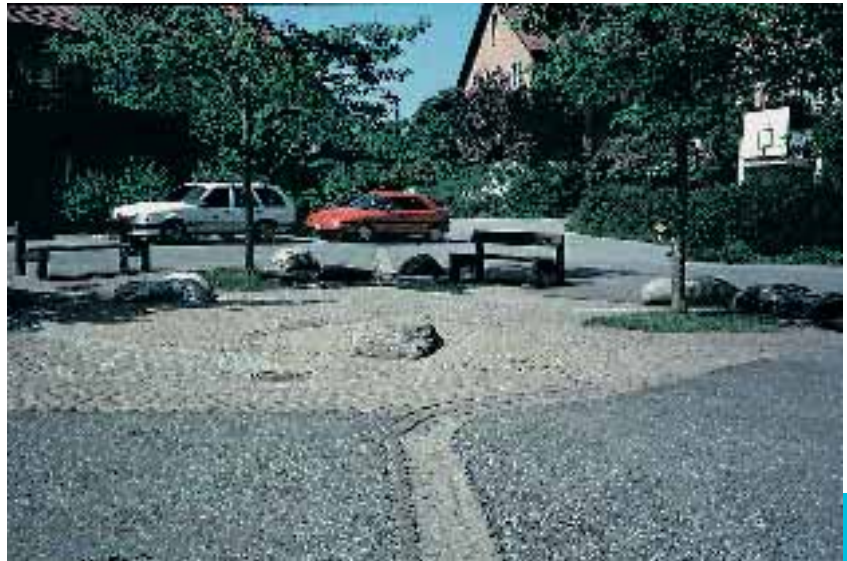
Offene Rinnen im Strassenbereich zur Ableitung von Platz-, Strassen- und Dachwasser
