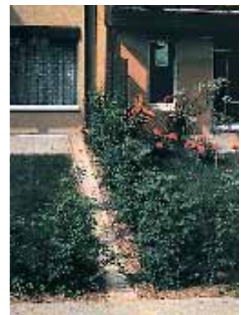
In einer offenen Rinne gelangt das Dachwasser zur Strasse
