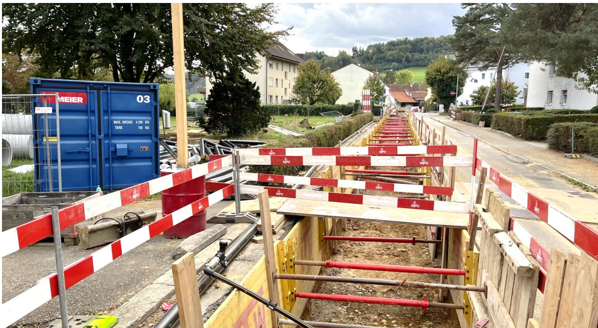
Bau der Fernwärmeleitungen in Frenkendorf (koordiniert mit dem Ersatz weiterer Werkleitungen und den nötigen Strassensanierungen)
